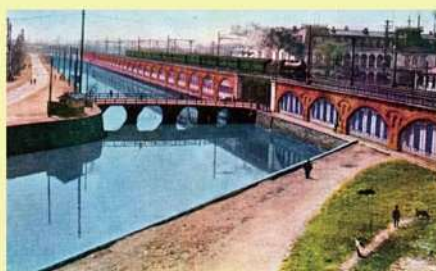
外濠沿いの新永間市街線高架線
