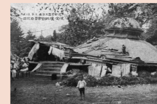
日比谷音楽堂倒壊実況 大正12年(1923)
