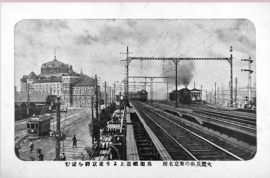
高架鉄道より東京駅を望む
